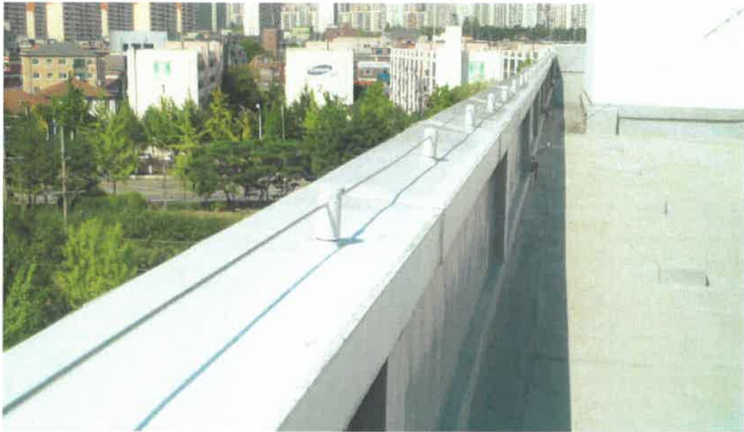
▲ 알루미늄 / 폴리카본지지금구 시공
