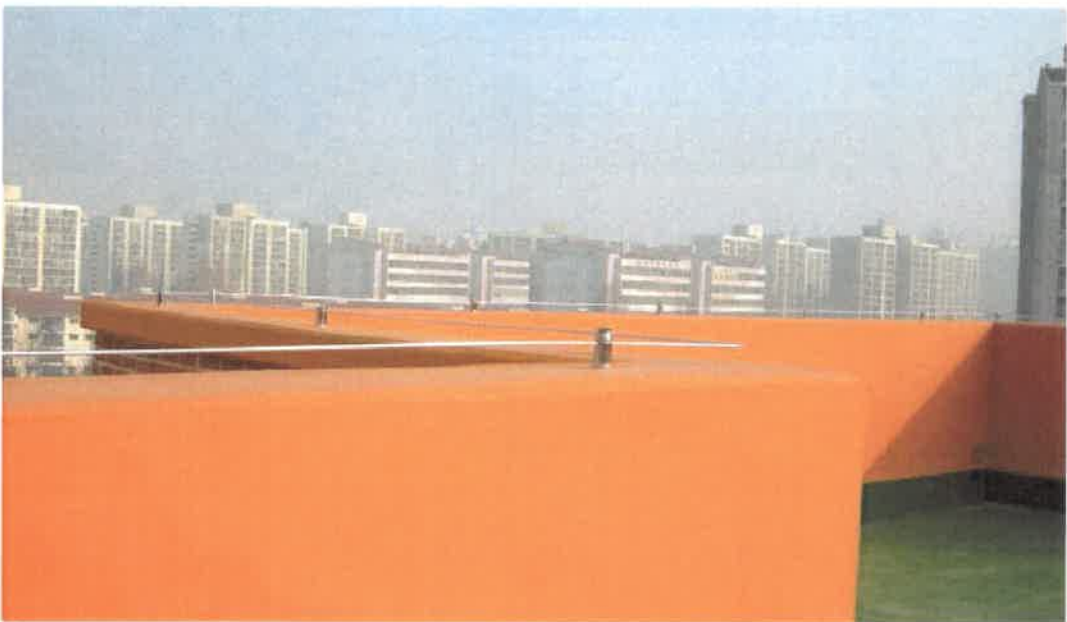
▲ 알루미늄 / 알루미늄지지금구 시공
